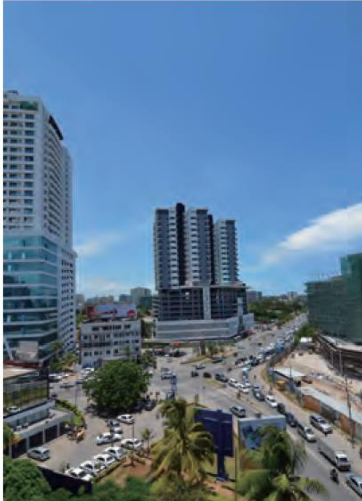
Dal es Salam: construction des bâtiments élevés
